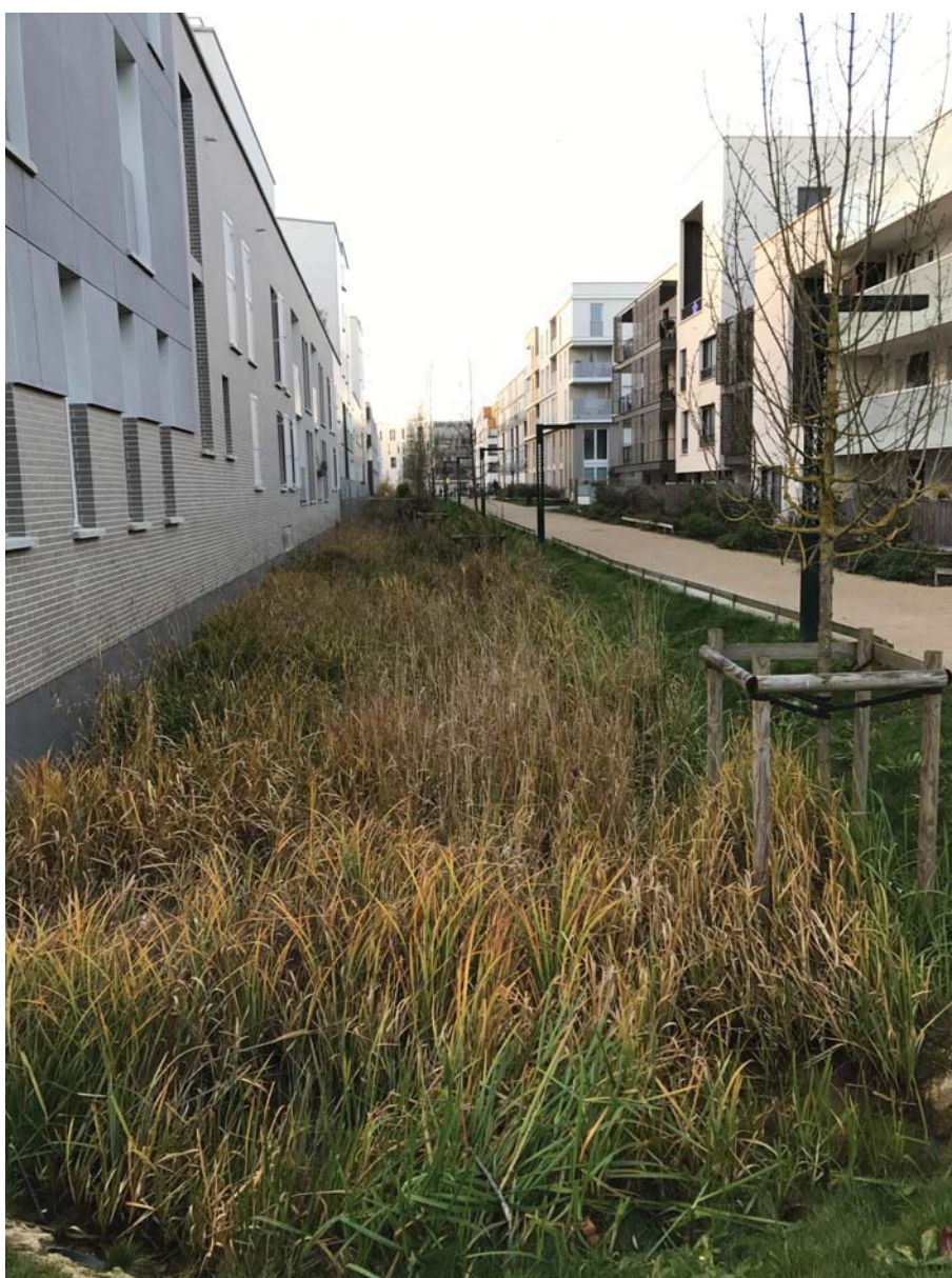
Exemple de noue à Palaiseau
