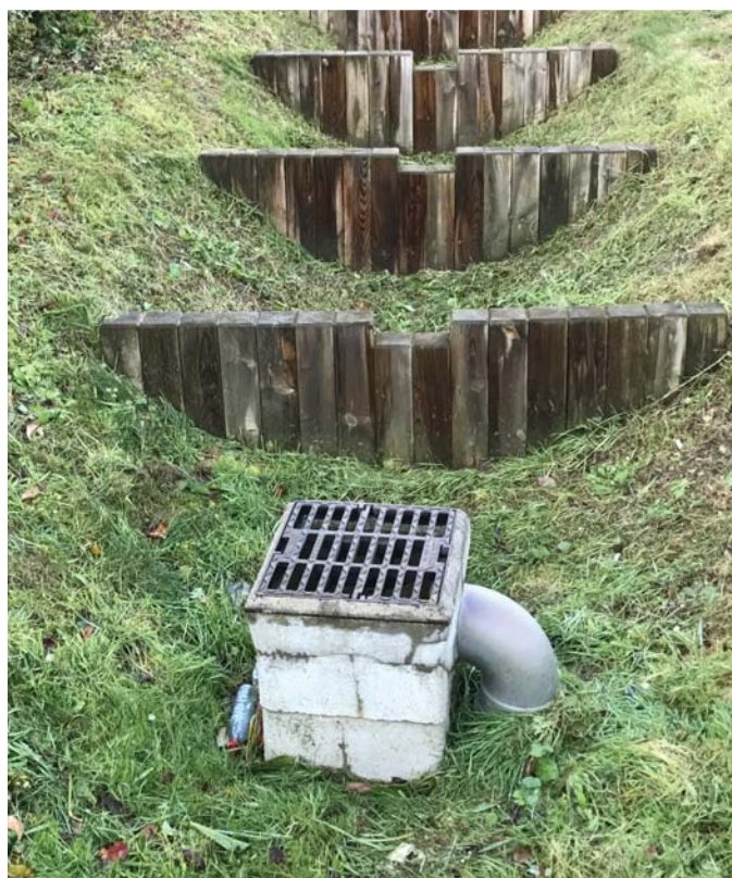
Noue à Vauhalla
